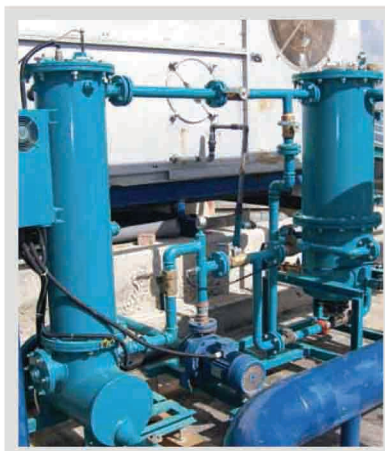
型号SR-05电解析除垢杀菌器与WSMF-20的安装
