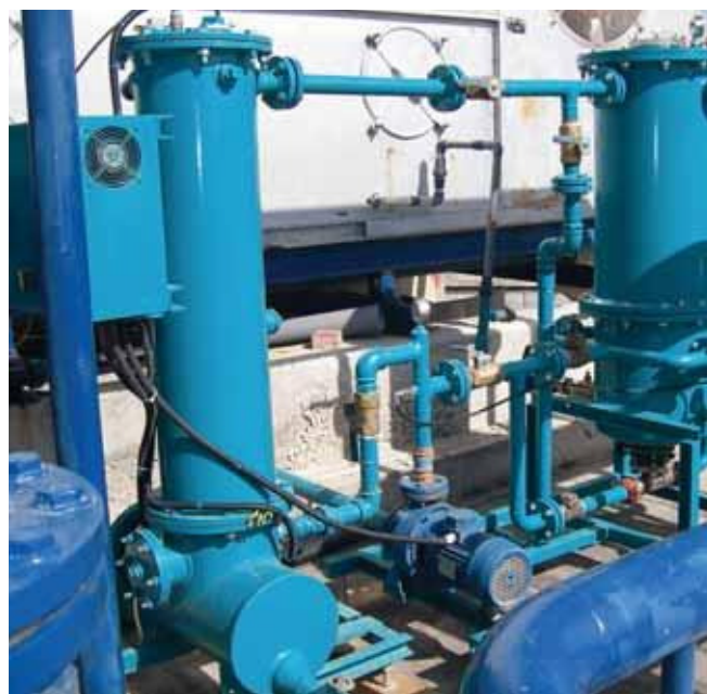
התקנת מפנה אבנית דגם SR-05 ופילטר בול טק אנרג' דגם SF-20-04
